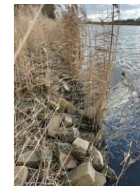
Proeftuin taludbescherming: GEO-wall stortsteen, houten taludbakken (van damwandplanken), BESE-elementen op Westfriese Vaart
