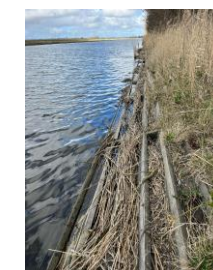
Proeftuin taludbescherming: GEO-wall stortsteen, houten taludbakken (van damwandplanken), BESE-elementen op Westfriese Vaart
