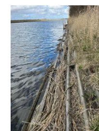
Proeftuin taludbescherming: GEO-wall stortsteen, houten taludbakken (van damwandplanken), BESE-elementen op Westfrieze Vaart 50 m
