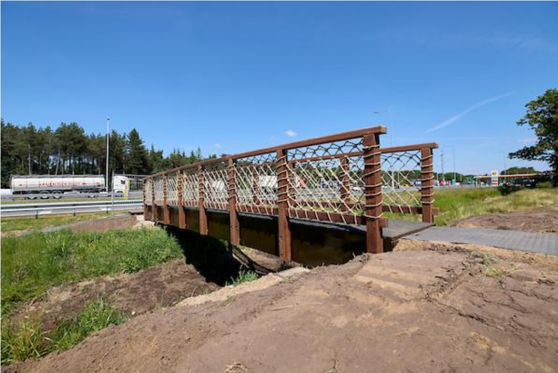
Voetgangersbrug van hout, vlas en hennep
