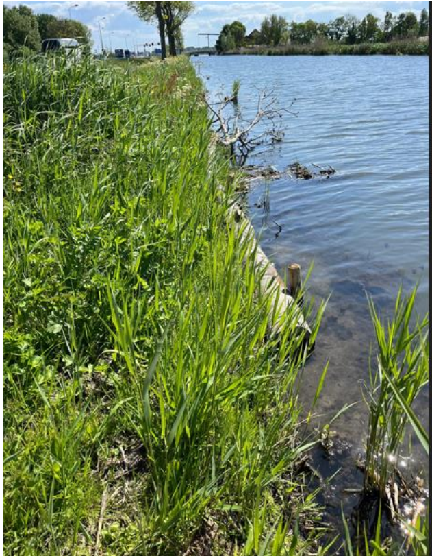
Westfriese Vaart: damwand onder de waterlijn, golfbreker van houten palen
