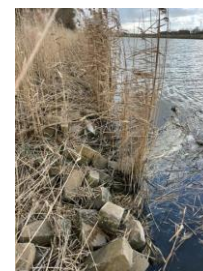
Proeftuin taludbescherming: GEO-wall stortsteen, houten taludbakken (van damwandplanken), BESE-elementen op Westfrieze Vaart 50 m
