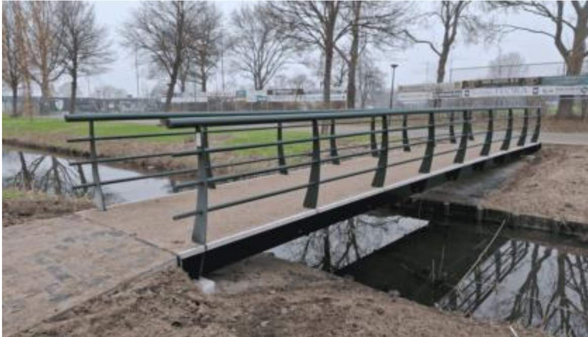
Nieuwe brug Maassluis komt uit Pijnacker
